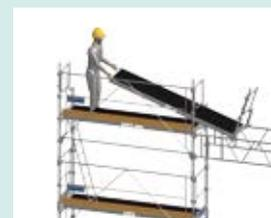
Mise en place des planchers en sécurité grâce au chariot à faire rouler le long des traverses des poutres aluminium.
