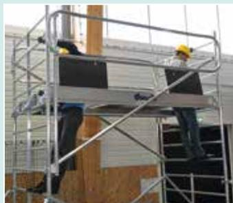
**ÉCHAFAUDAGE ÉQUIPÉ DE GARDE-CORPS MONOBLOCS EXMDS2\* ET DE PLANCHERS ALTO (2 trappes + plinthes intégrées).**
